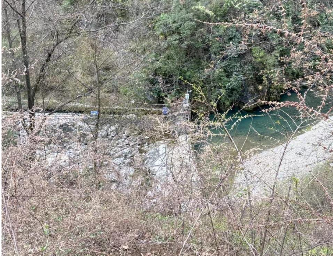
拦河坝及明渠
