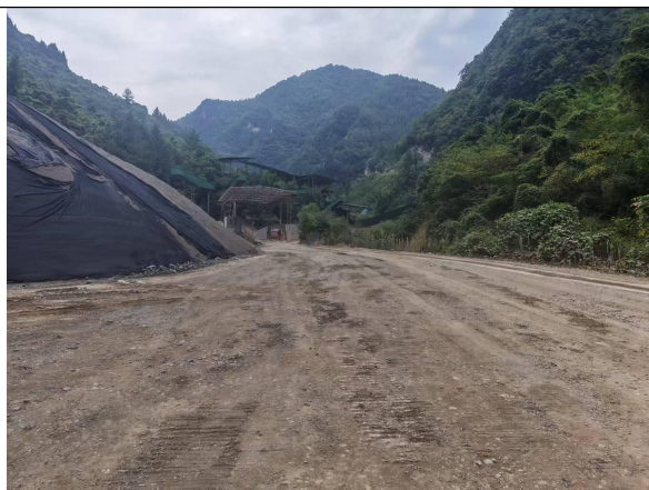
照片 1-1 进场道路
