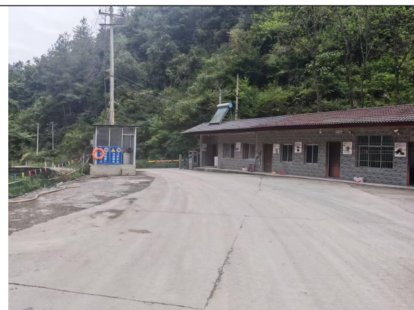
照片 1-3 临时生活区
